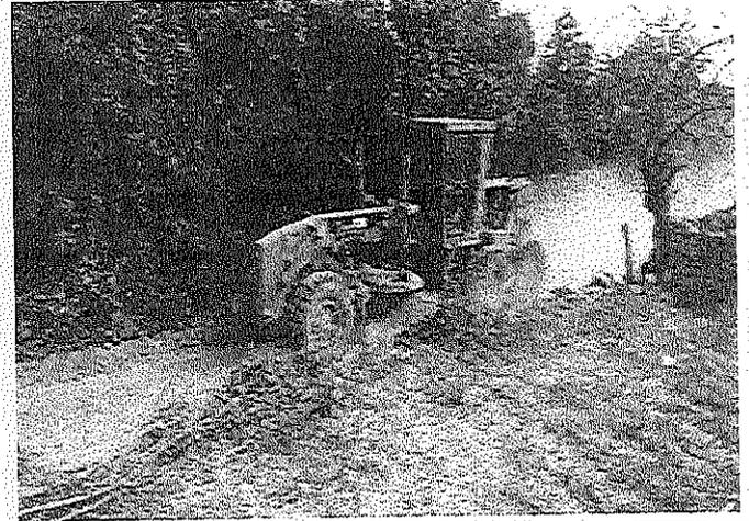
Foto 10: PERFILADO DEL TRAMO ANCHEANDO LAS PARTES MAS ESTRECHAS.
