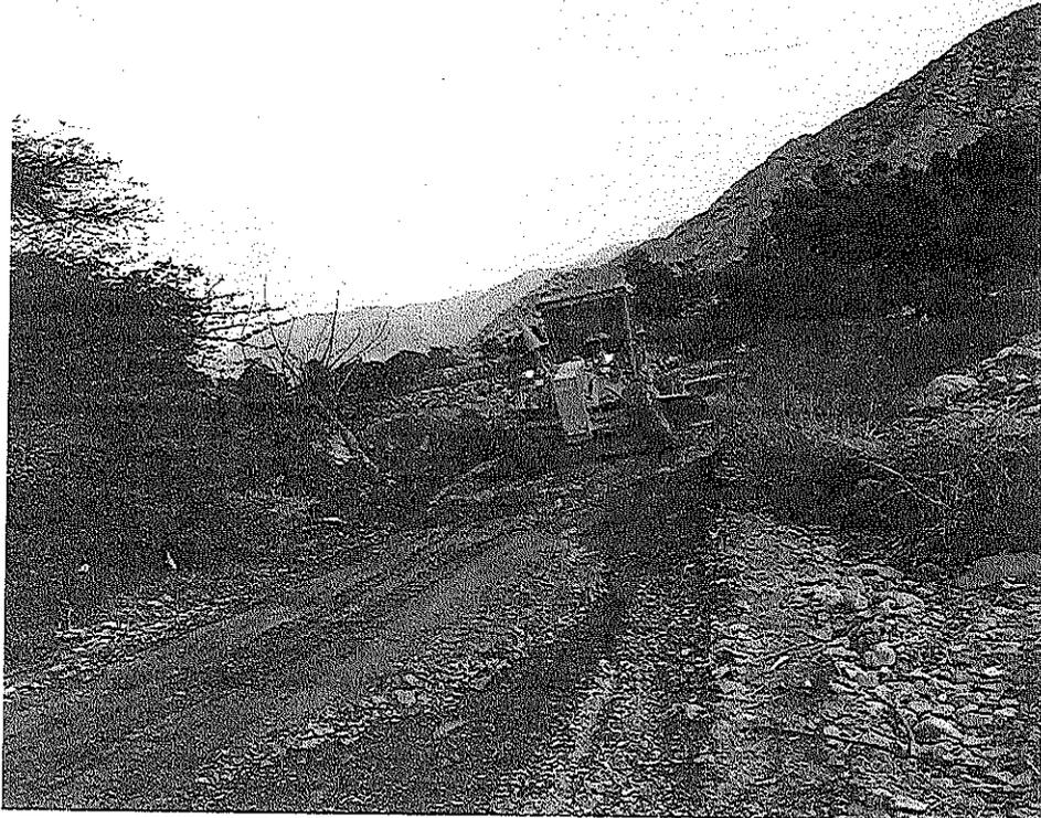
FOTO N° 07. Extendido y batido de material con La motoniveladora por el KM 4+700 al km 5+300.
