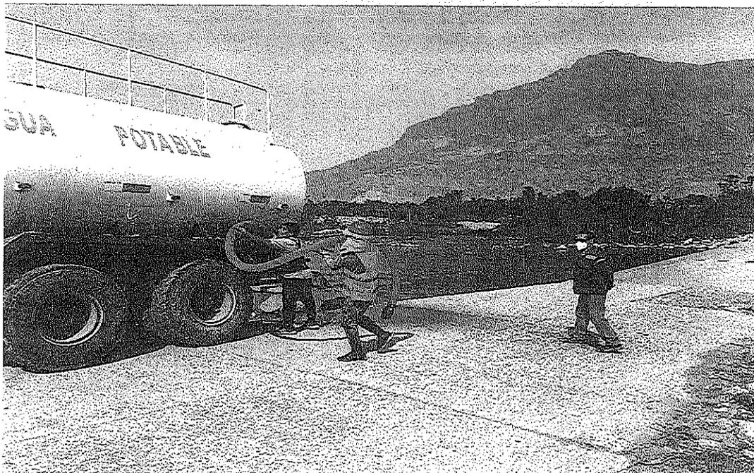
FOTO N° 06. El Inspector está realizando la inspección del llenado de la cisterna para el regado para la mitigación del medio ambiente y a la misma vez que se está regando para que luego se realice el expandido del material.
