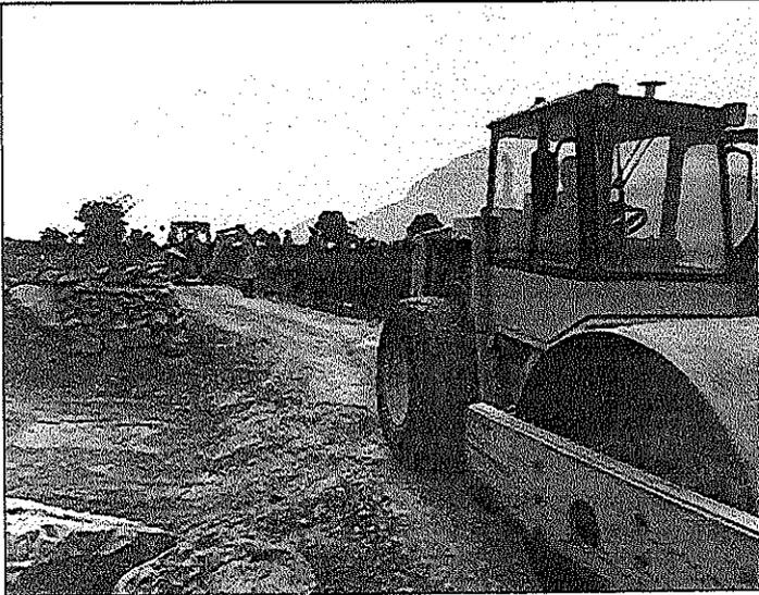
Foto 13: EXTENDIDO DE MATERIAL EN EL TRAMO PARA LUEGO REGARLO
