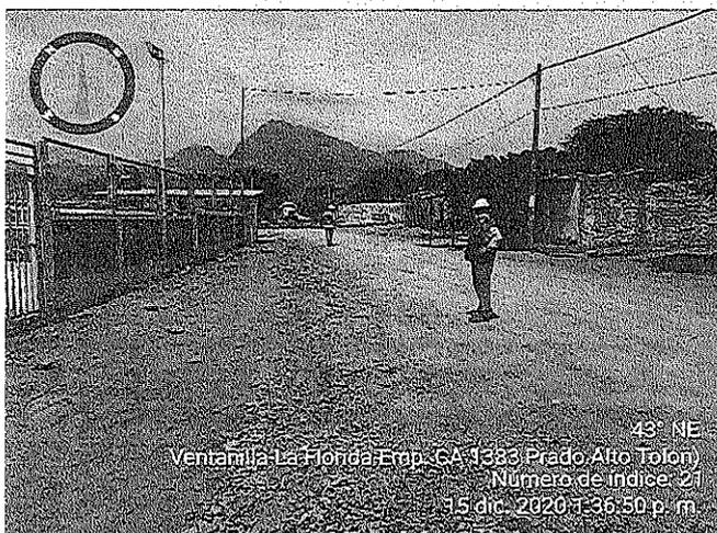
FOTO N° 16, 17 Y 18. VERIFICACION CON EL INSPECTOR DE ANCHOS DE CALZADA Y TRABAJOS REALIZADOS, COMO SE VISUALIZA HAY TRAMOS DE ANCHOS DE 7.50 M, MAS DE LO OFERTADO DE 3.60 M.
