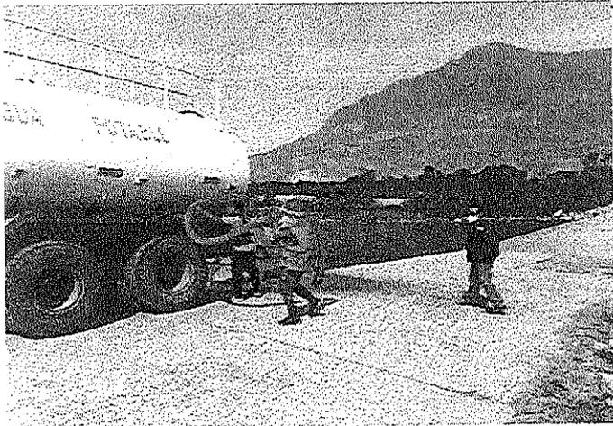
Foto 07: LLENADO DE LA CISTERNA EN LA FUENTE DE AGUA DEL BADEN DE TOLON PARA REGAR EL AFIRMADO EN CANTERA Y TRAMO.
