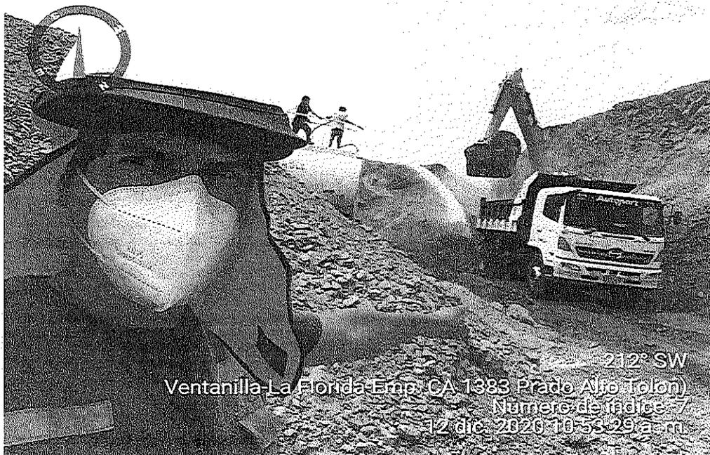
FOTO N° 02. Extracción y acumulación de material, los que son mezclados hasta lograr su homogeneidad.
