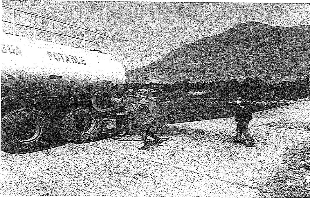
**FOTO N° 01. Inspección del llenado de la cisterna para el regado para la mitigación del medio ambiente y a la misma vez que se está regando para que luego se realice el expandido del material.**
